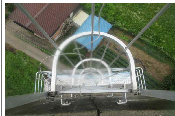
점검사다리 상태양호 P1
