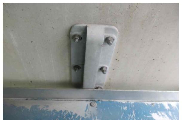
점검통로 고정장치 상태양호 P1
